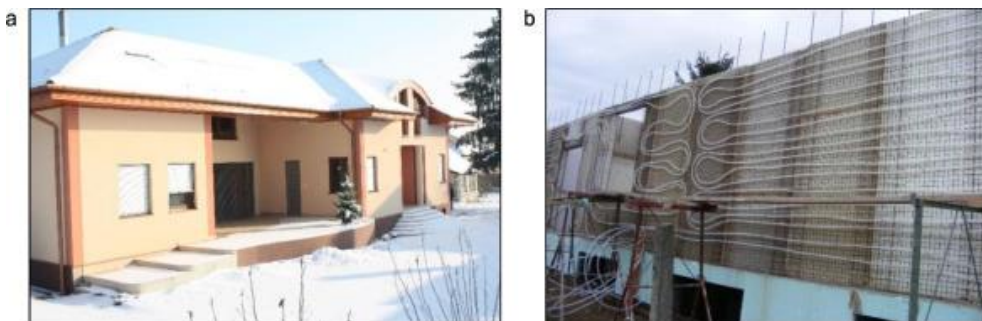
Obrázok 2.0.11 (a) Pohľad na západnú fasádu budovy (b) Usporiadanie výmenníka tepla v stene prízemnia (Kisilewicz a kol., 2019).
