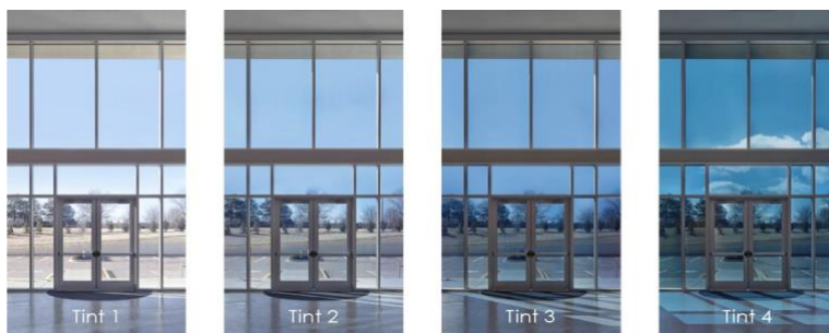
Obr. 2.11 Elektrochromické zasklenie – postupné štádiá stmavovania od číreho po úplne stmavený stav, (Konis & Selkowitz, 2017)
