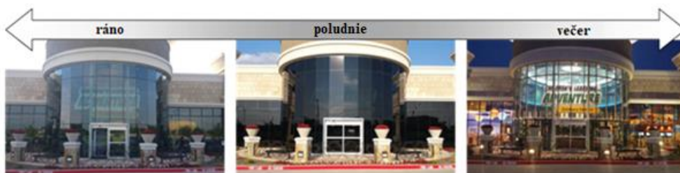
Obr. 2.8 Pohľad na presklenú fasádu z FCZ počas fáz dňa, ("Web page: https://www.commercialwindows.org/thermochromic.php [online 29.08.2020],")
