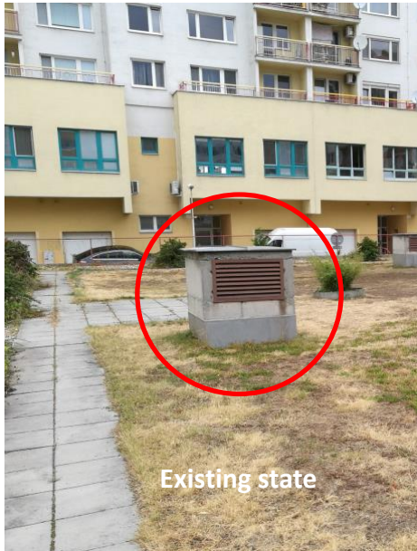
6.6.6. ábra - A szellőzőakna körüli kavicsréteg hiányzó sávja; a zöldfelület alatti tetőrétegeken átvezető metszet megfelel a meglévő állapotnak.
