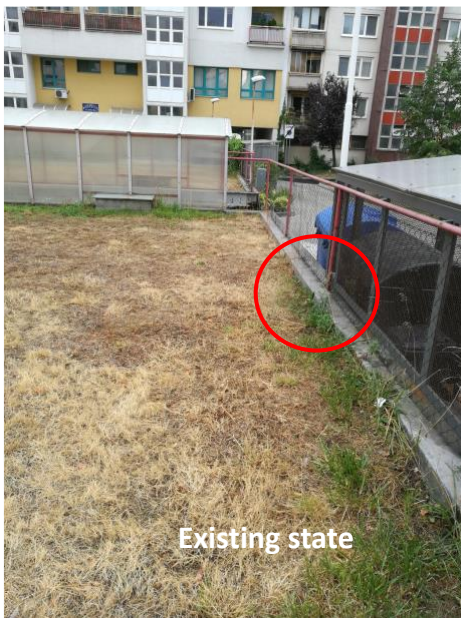
6.6.7. ábra - A korlátot helytelenül rögzítették az építményhez; a zöldfelület alatti tetőrétegeken átívelő szakasz megfelel a meglévő állapotnak.
