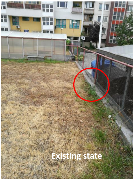
Obrázok 7 - Zábradlie nesprávne ukotvené do konštrukcie; rez vrstvami strechy pod zeleňou zodpovedá existujúcemu stavu
