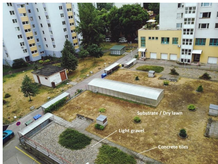
Obrázok 4 – Pohľad na vegetačnú strechu podzemnej garáže
