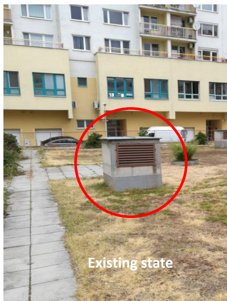
Obrázok 6 - Chýbajúci pás štrkovej vrstvy okolo vetracej šachty; rez strešnými vrstvami pod zeleňou zodpovedá existujúcemu stavu
