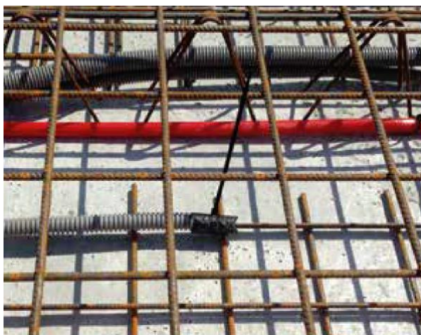
Obrázok 6. Snímač inštalovaný počas konštrukčnej fázy [2]
