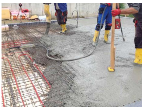
Obrázok 9. Ukladanie betónu na rúrky a snímače v jadre [2]
