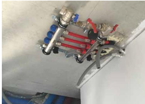
Obrázok 10. Inštalácia rozdeľovača a distribučných armatúr [2]
