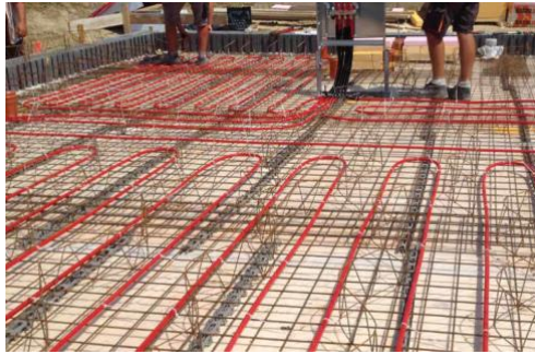
10. ábra. A csőrendszer fektetése [2]
