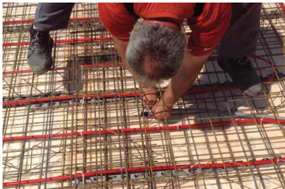
11. ábra. A maghőmérséklet-érzékelők felszerelése [2]
