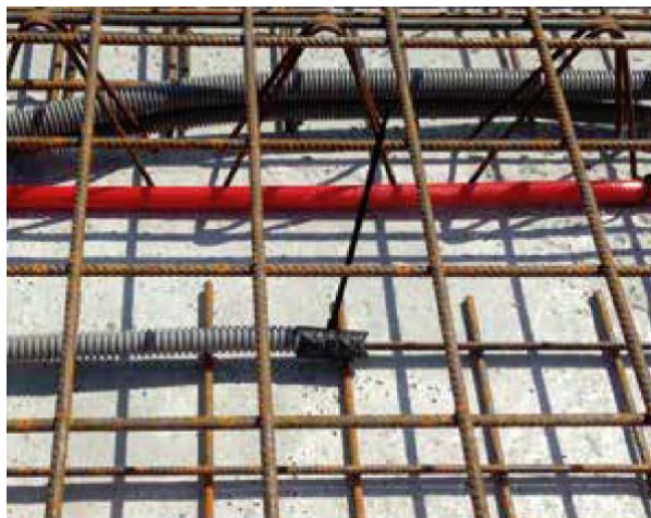
8. ábra: Az építési fázisban telepített érzékelő [2]
