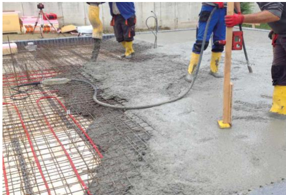
12. ábra. A csőrendszer és a magérzékelők betonozása [2]
