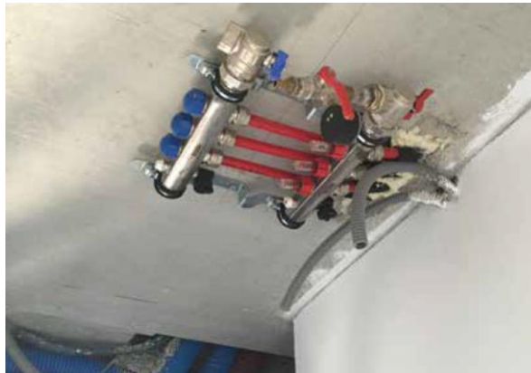
13. ábra. A kollektor és az elosztó szerelvények felszerelése [2]
